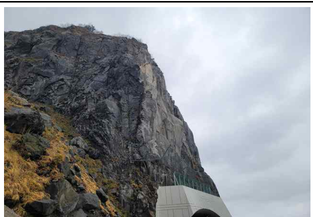
종점측 터널부사면 전경
